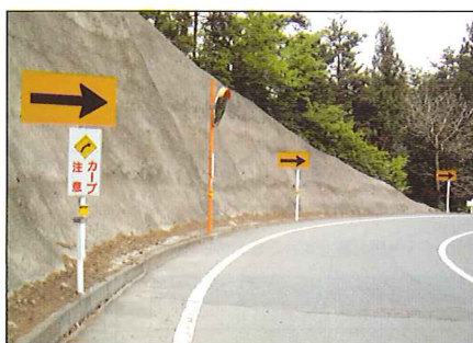
矢印板支柱取付 (φ76.3 取付バンド) カーブミラー (φ89.1 SUS-1/バンド)
