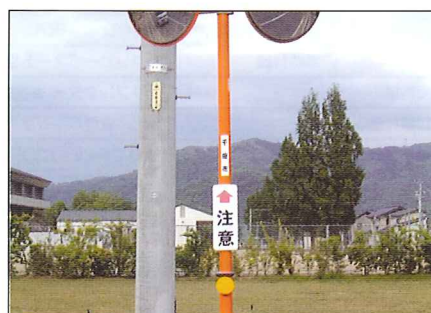
カーブミラー支柱取付 (φ76.3 取付バンド)
