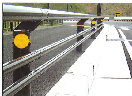
A 種ガードパイプ支柱取付 (SUS-1/バンド)
