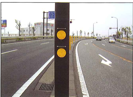
信号機柱取付 (SUSバンド)
