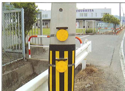
電柱取付 (SUSバンド)
