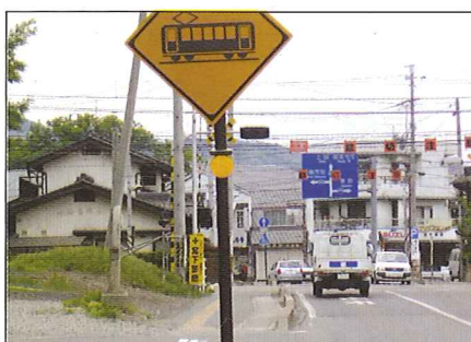
警戒標識支柱取付 (φ60.5 取付バンド)
