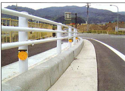
B-C 種ガードパイプ支柱取付 (φ114.3 取付バンド)
