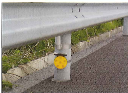
A 種ガードレール支柱取付 (SUS-1/バンド)
