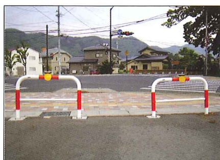
車止め(横パイプ)取付 (φ60.5 取付バンド)
