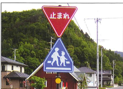
規制・指示標識支柱取付 (φ60.5 取付バンド)
