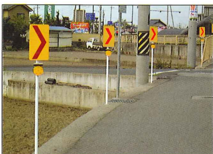
線形誘導標支柱取付 (φ34 取付バンド)
